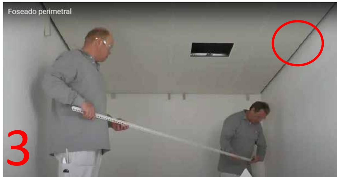
DILATACIONES O PERFILERÍA PARA ACABADOS EN DRYWALL Y/O FIBROCEMENTO
