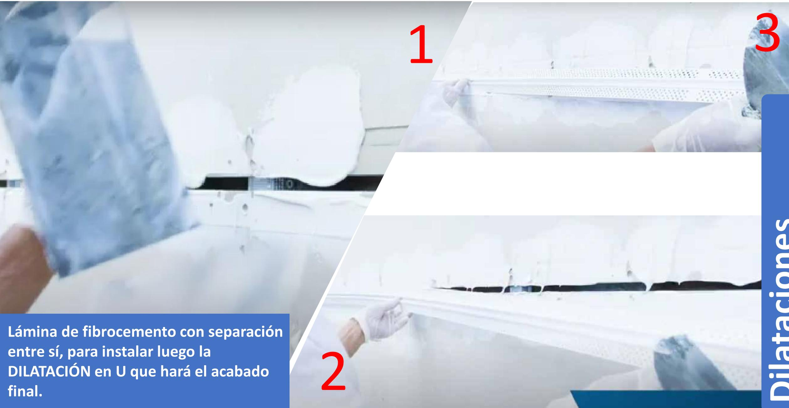
Lámina de fibrocemento con separación entre sí, para instalar luego la DILATACIÓN en U que hará el acabado final.
